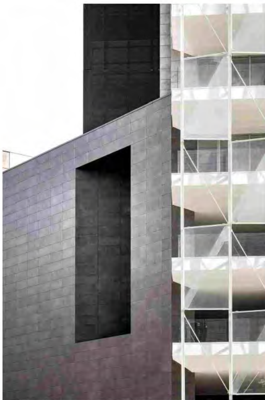
De Castilia 23, Milano | facciata ventilata: sistema Granitech, superfici Flandre Core Shade Active
